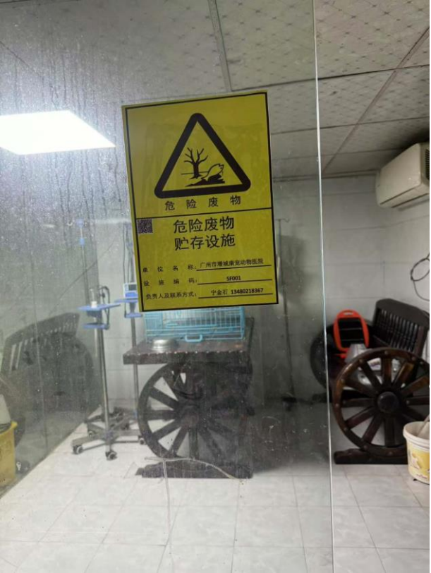
图 2-5 现有项目医废危废暂存间
