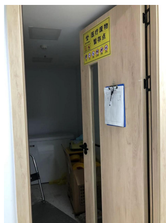
图 2-6 医废危废暂存间
