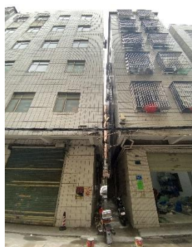
项目南侧（居民楼）
