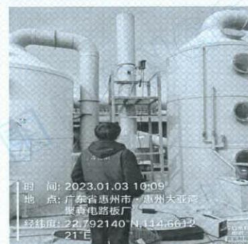
图 22: DA017 废气排放口 (2023.01.03)
