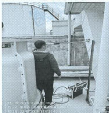
图 45: DA018 废气进气口 2# (2023.01.08)
