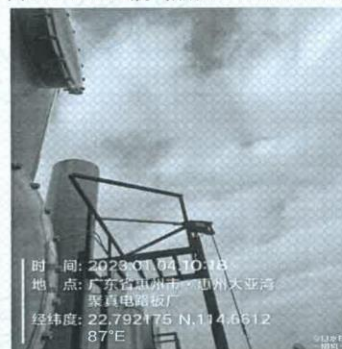
图 32: DA017 废气排放口 (2023.01.04)
