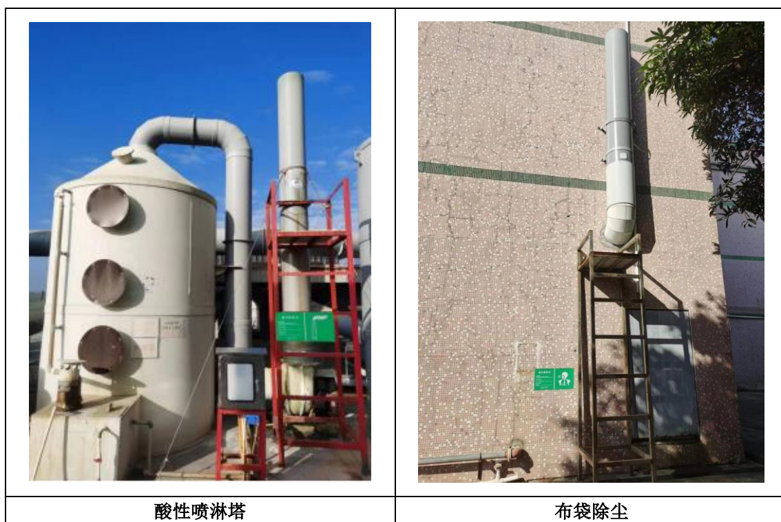
图 4.1-3 废气处理设施部分照片
