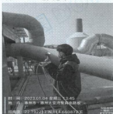
图 39: DA012 废气进气口 (2023.01.04)
