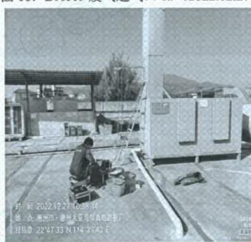
图 20: DA009 废气排放口 (2022.12.27)
