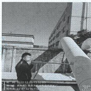
图 11: DA021 废气进气口 2# (2022.12.25)
