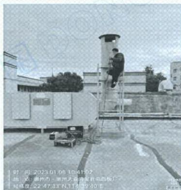
图 46: DA018 废气排放口 (2023.01.08)
