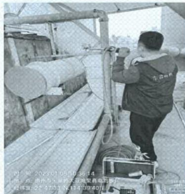
图 44: DA018 废气进气口 1# (2023.01.08)
