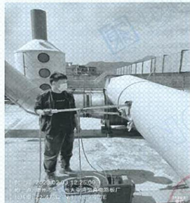
图 3: DA004 废气进气口 (2023.02.03)
