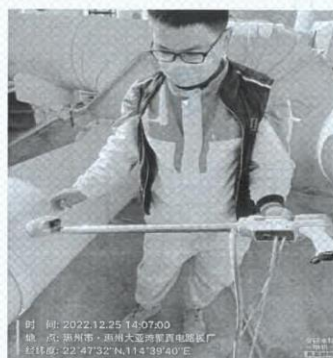
图 12: DA021 废气进气口 3# (2022.12.25)
