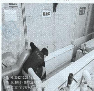
图 14: 生产废水排放口 第二次 (2022.12.27)
