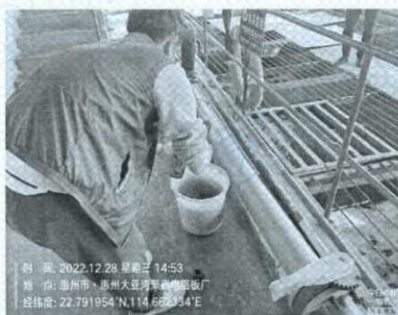
图 29: 综合废水池 第一次 (2022.12.28)
