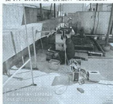
图 19: DA009 废气进气口 2# (2022.12.27)
