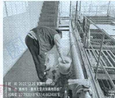
图 32: 综合废水池 第四次 (2022.12.28)
