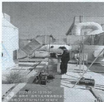
图 35: DA003 废气进气口 (2023.01.04)
