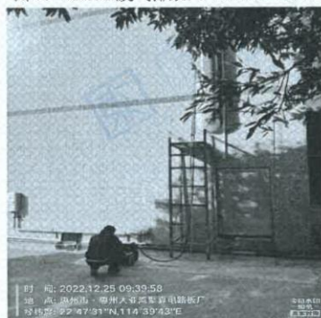
图 9: DA006 废气排放口 (2022.12.25)
