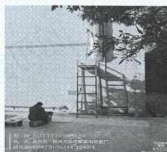
图 2: DA006 废气排放口 (2022.12.24)
